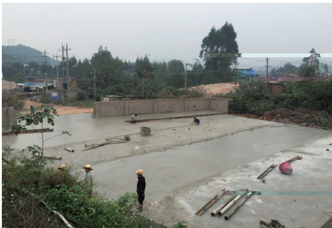
环城友谊地块停车场场地硬化工程完工
